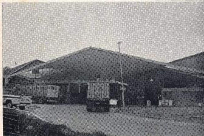
Fig. 1.—Cubierta constituida por láminas postensadas en paraboloides hiperbólicos. El nervio de borde tiene 40 metros de luz con una altura de 0,42 m. Planta Schcolnik, Partido de Morón. Ings. Justo Segura Godoy y Juan Snitcofsky.
